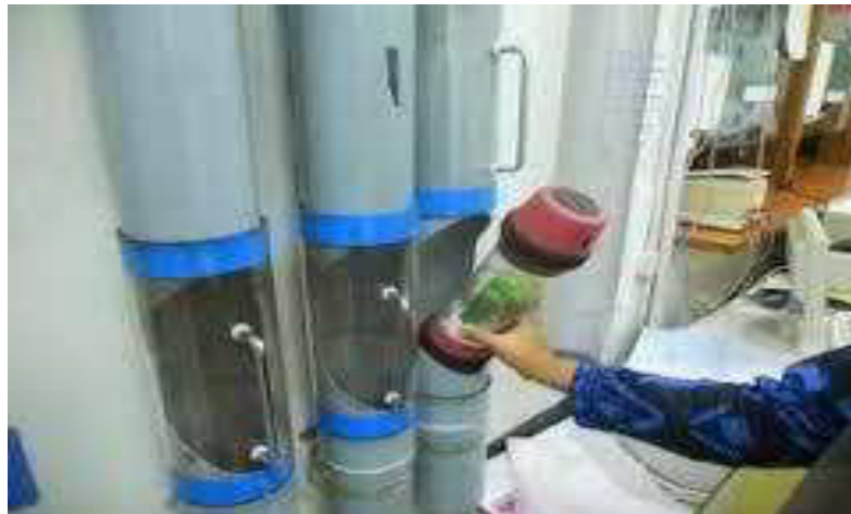
Gambar 5.19 kegiatan distribusi rekam medis menggunakan Pneumo tube
